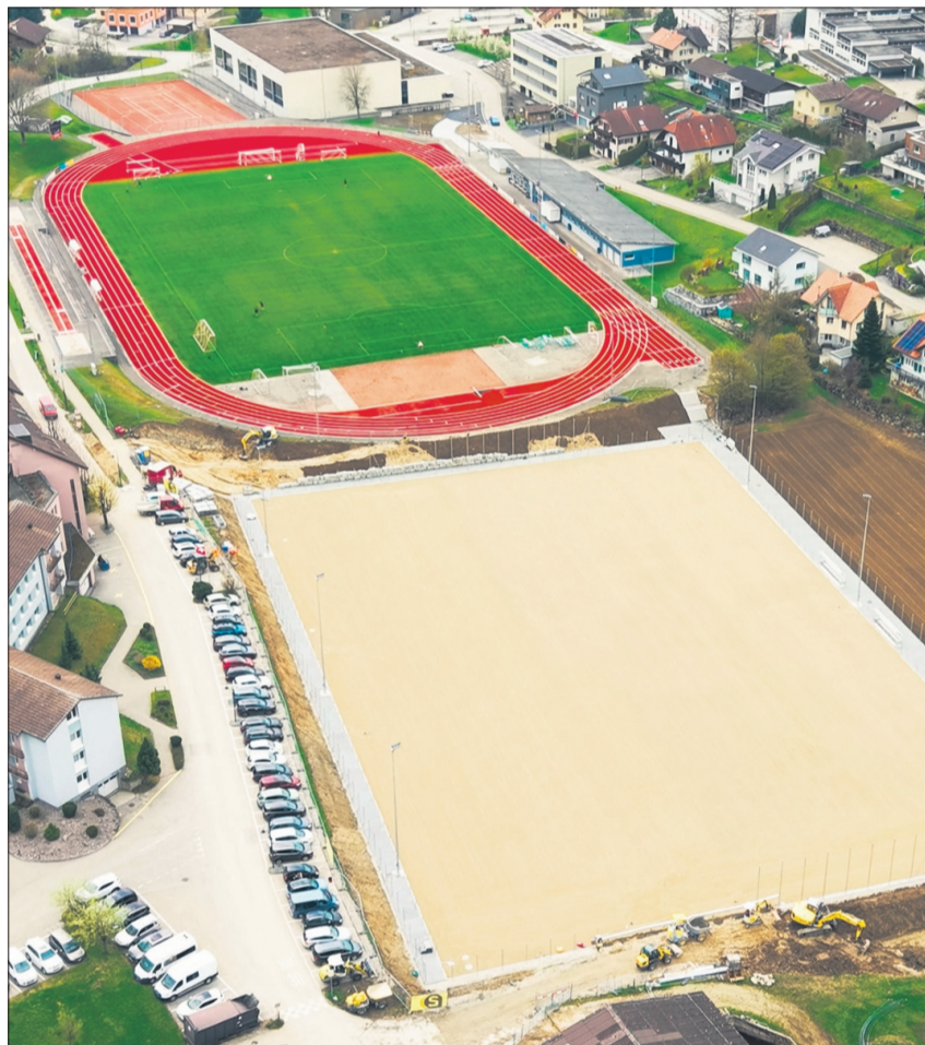
Die Flutlichtmasten sind beim Kunstrasenplatz installiert worden. Die Verlegung des Kunstrasens steht demnächst an. [Bild Livio Krummenacher]
