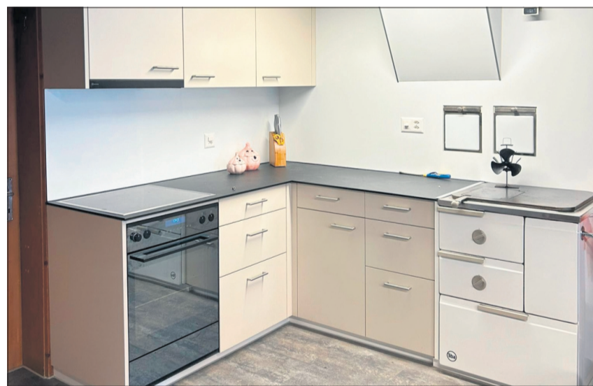
Der gelungene Umbau der Küche auf der Alp Salzbühl. [Bild zVg]
