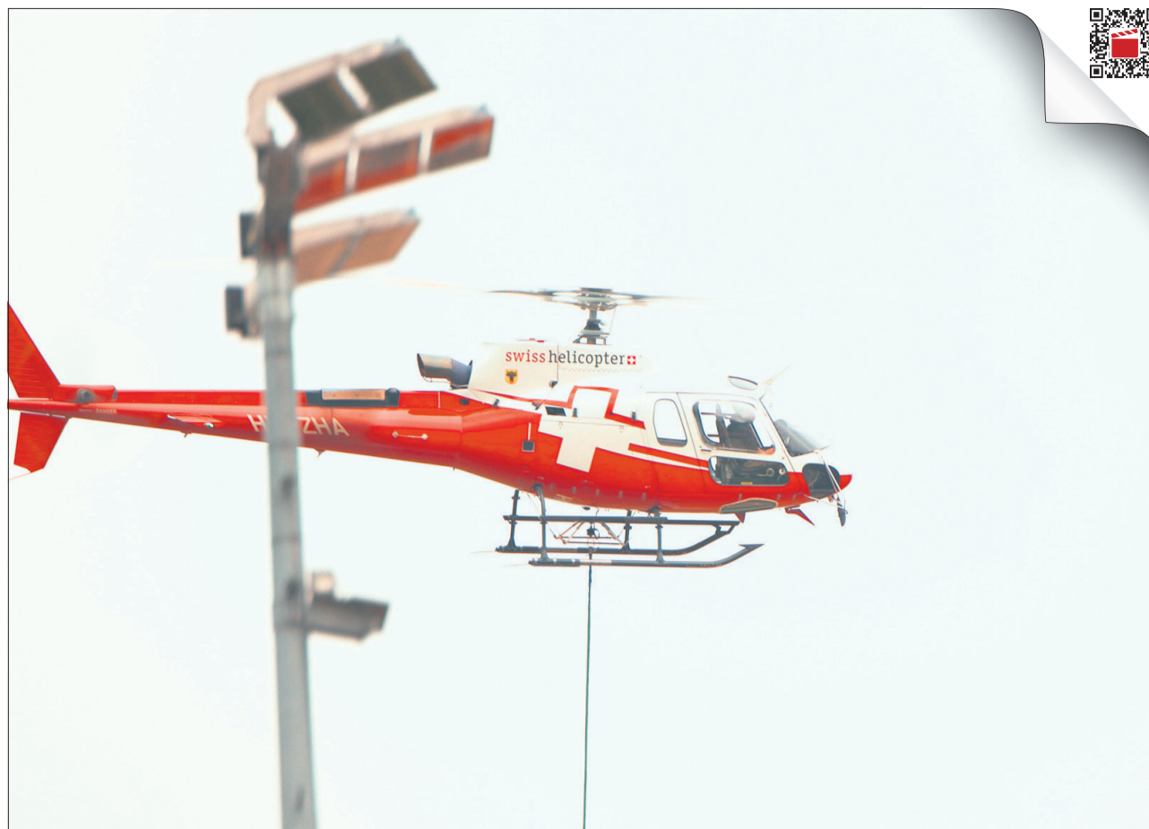
Die Flutlichtmasten werden mit dem Helikopter auf die Sportanlage geflogen. [Bild Livio Krummenacher]
